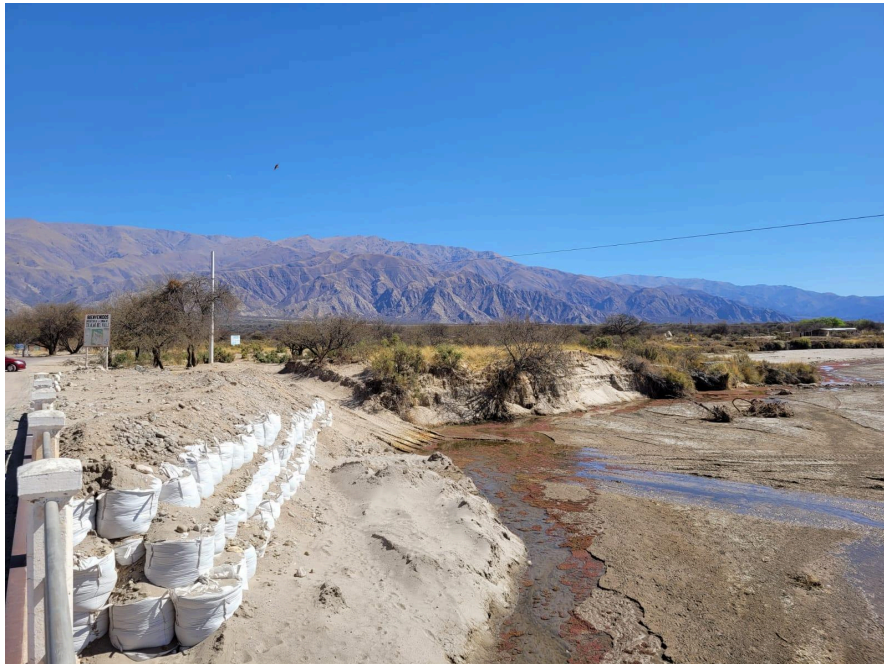
Imagen: reconstrucción del puente sobre el río Santa María después de una crecida, propia.
