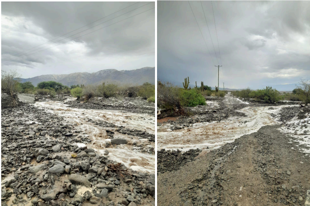
Imágenes: daño de caminos por lluvia torrencial en Amaicha del Valle, cortesía de Rody Villalba.
